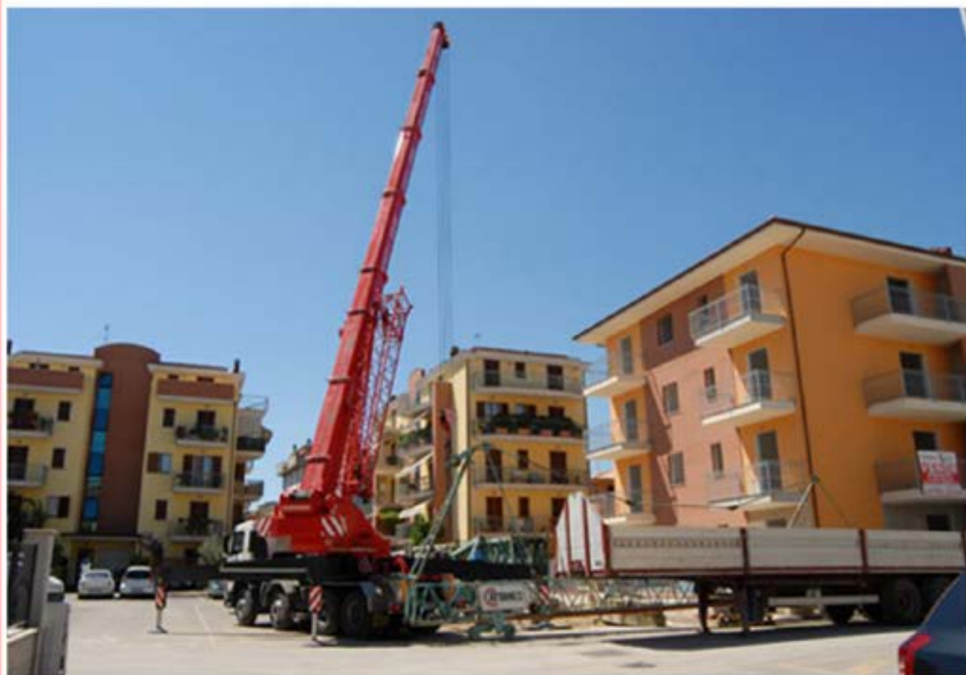
Smontaggio Gru Edile Autogru T150
